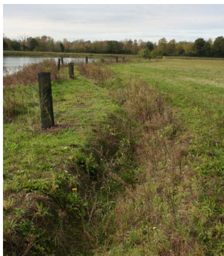
← ↑ Exemples de fossé empêchant le ruissellement direct des eaux vers un plan d'eau
