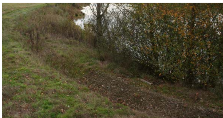
← ↑ Exemples de fossé empêchant le ruissellement direct des eaux vers un plan d'eau
