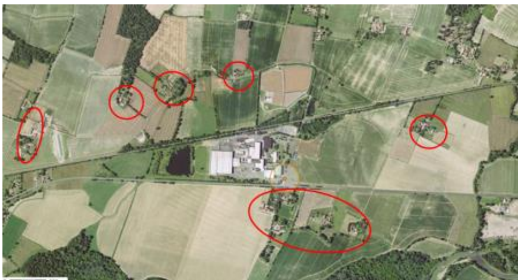
Vue aérienne de l'usine SOLEAL Bonduelle dans son environnement (source : Géoportail) : cerclé de rouge les zones habitées les plus proches de l'usine.
