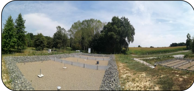
Station d'épuration de MAURRIN
