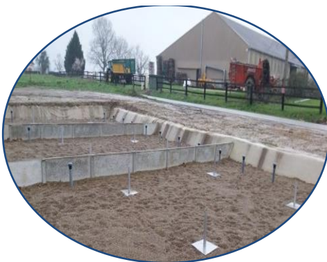
Station d'épuration de ARTASSENX
