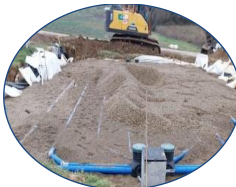
Station d'épuration LUSSAGNET
