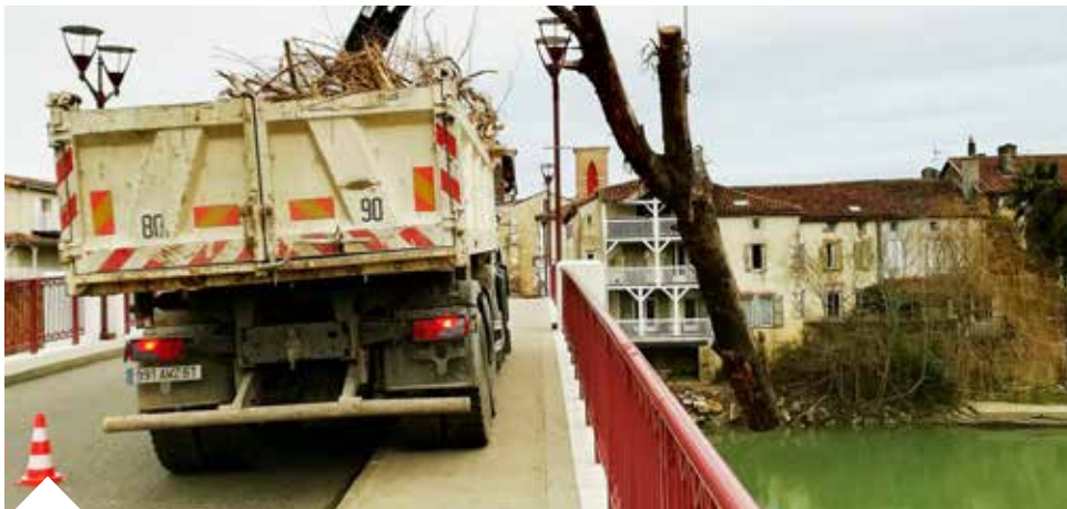
L'enlèvement des embâcles aux abords des ponts permet de maintenir le libre écoulement des eaux.
