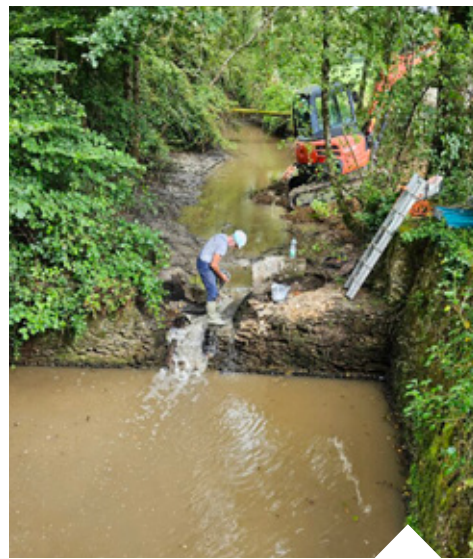
Le démantèlement d'un seuil sur le cours d'eau du Courdaoute s'est achevé fin juillet.
