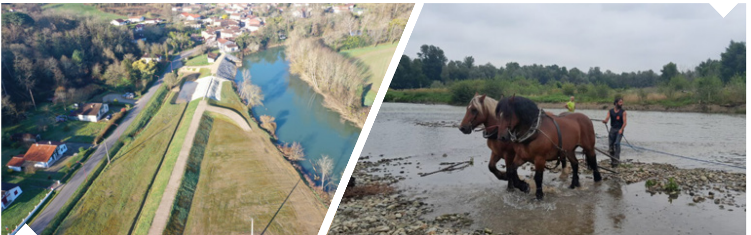
Vue aérienne de la digue de Pénich-Laburthe dont les travaux ont été achevés en décembre 2023.
