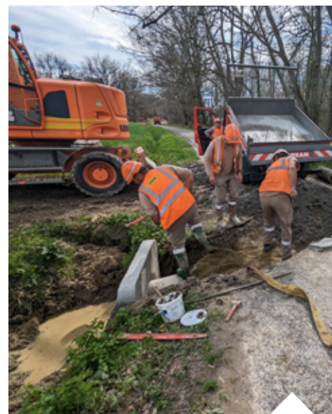
Plusieurs réparations de busages ont été réalisées en 2024.
