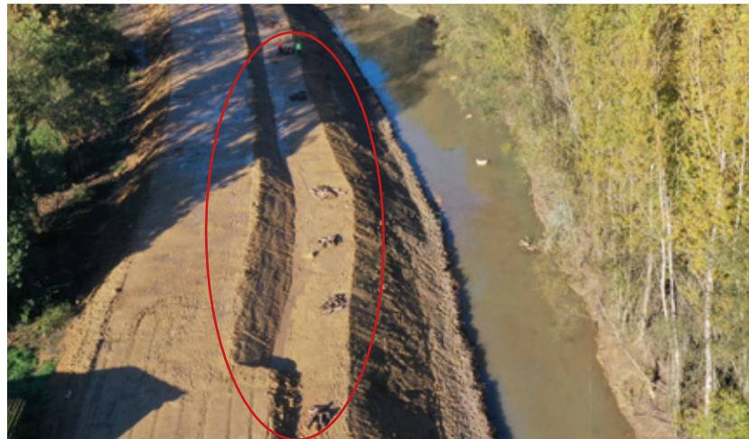
*Vue aérienne de la digue : des pieux et des fascines ont été installés sur le talus abrupt pour en limiter l'érosion lors des crues.*
