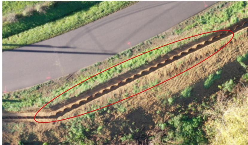
*Zone amont : la technique de la palplanche a été mise en œuvre. Les palplanches sont recouvertes d'une poutre de couronnement béton.*
